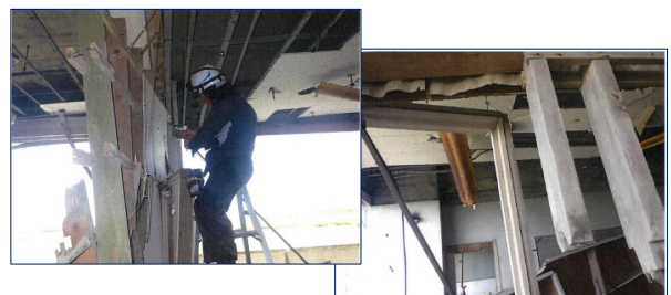
遺構の経年劣化部分の修繕 (3階仕切り壁の部分)
