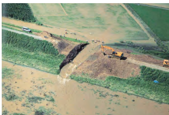
堤防を開削して排水（鎌巻地区）
