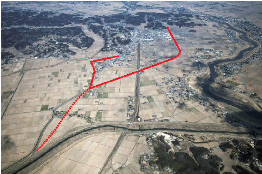
水害に強いまちづくり事業（二線堤バイパス）
