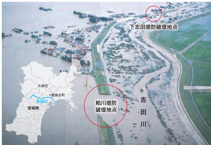
8.5吉田川豪雨災害で堤防が決壊（粕川、下志田堤防）
