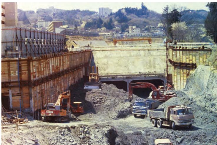
〈川内トンネル青葉山側ブロック完成後、中間ブロック付近の開削状況〉
