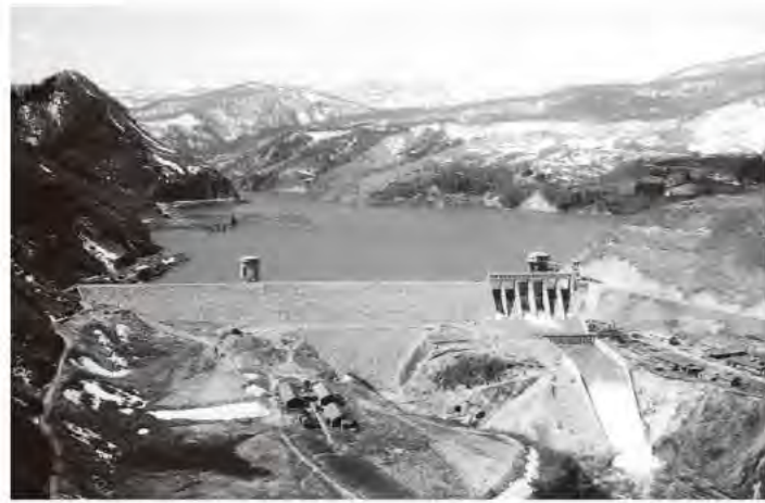
完成直後の石淵ダム
