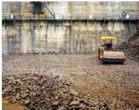
ロック部盛り立て振動ローラー転圧
