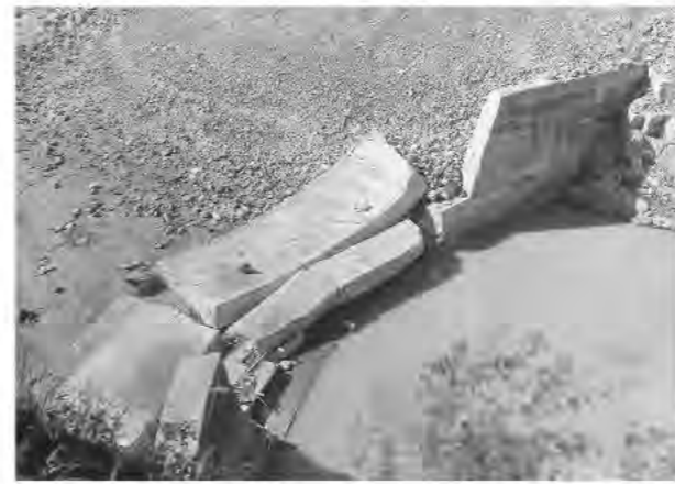
洪水で転倒した仮締切
