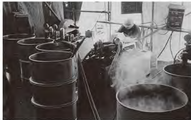
ダム右岸遮水工事プラント ※1
