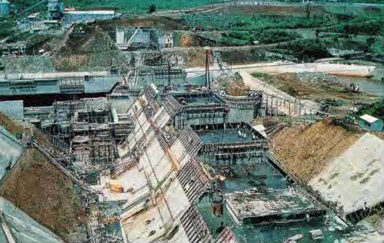
本体施工状況：左岸より右岸を望む (S41.6) ※1
