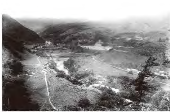
石淵ダム工事前の様子
