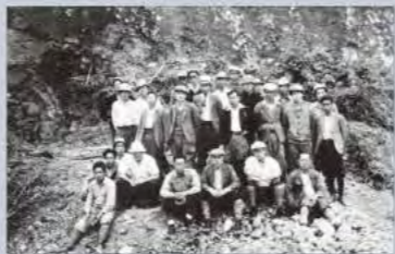
第1爆破工事（装薬完了記念）
