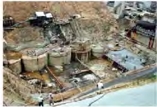
レジスティングブロック施工状況
