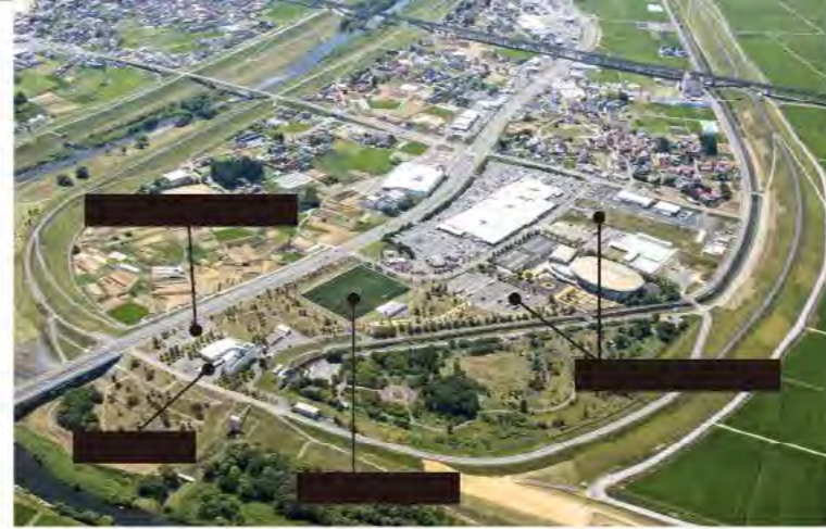
一関防災センター（あいぼーと）の災害対策機能
