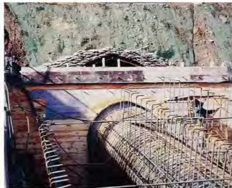
監査廊鉄筋組立
