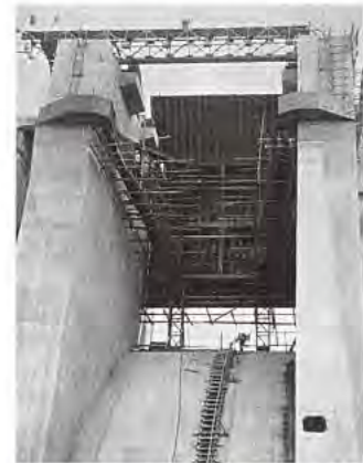
クレストゲート据付状況 (S42.7) ※1
