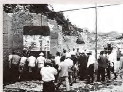
堤体コンクリート打設開始 (S26) ※1
