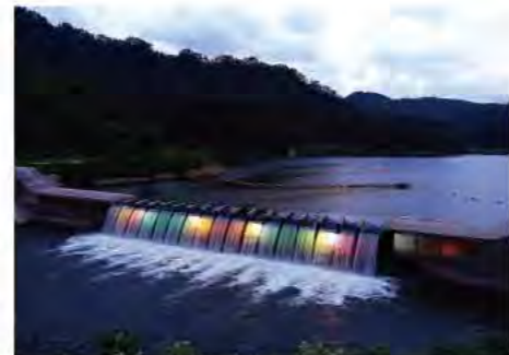
湯田ダム／錦秋湖（貯砂ダム）ライトアップ
