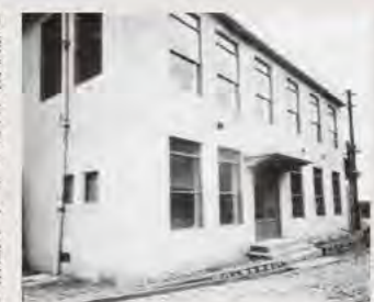
石淵堰堤管理所完成 (S29) ※1
