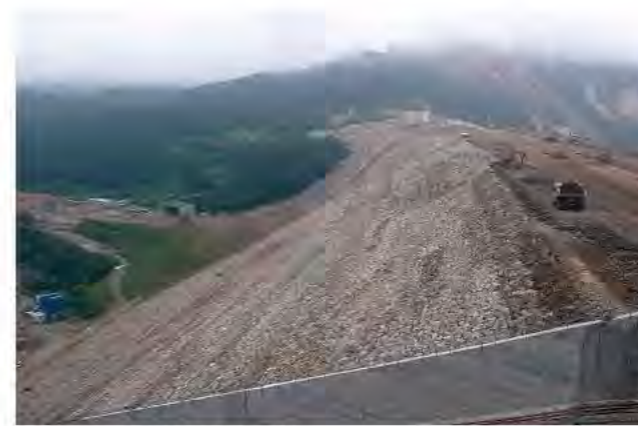
ICTによって施工が進む胆沢ダム
