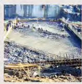
コンクリート打設
