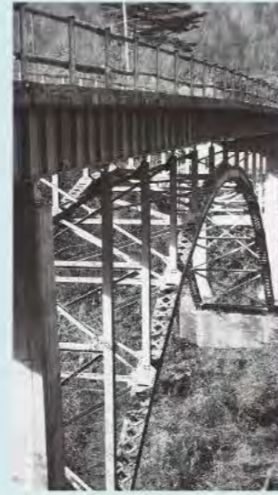
国道無地橋 トラス橋
