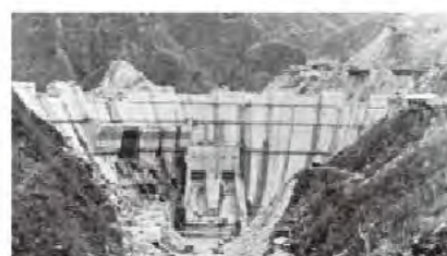
昭和38年7月(4年目) コンクリート打設30万m 3 達成、残り1年
