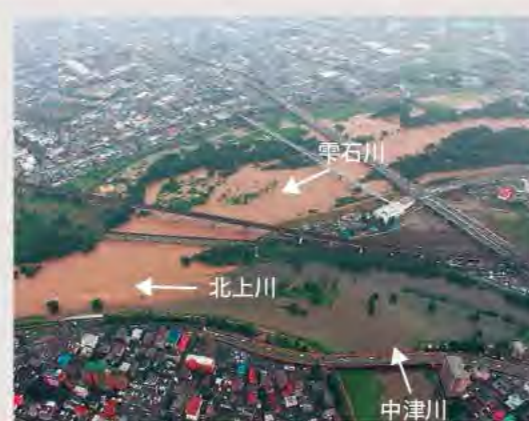
雫石川合流部付近の状況 (H25.8.9)
