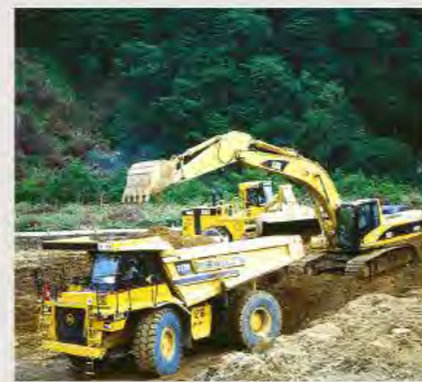
基礎掘削工事
