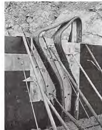
止水板の状況 (S40) ※1
