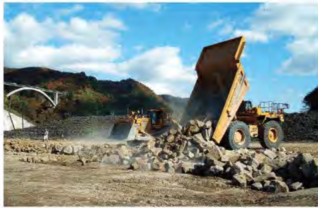
ロック材盛立工事の様子
