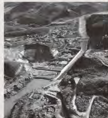
打設開始当時の状況(空撮) ※1
