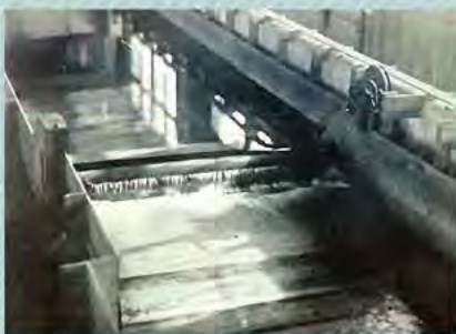
赤羽分室水理実験水路(降開式転動堰) ※1
