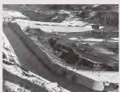
仮排水路第一次転流 ※1
