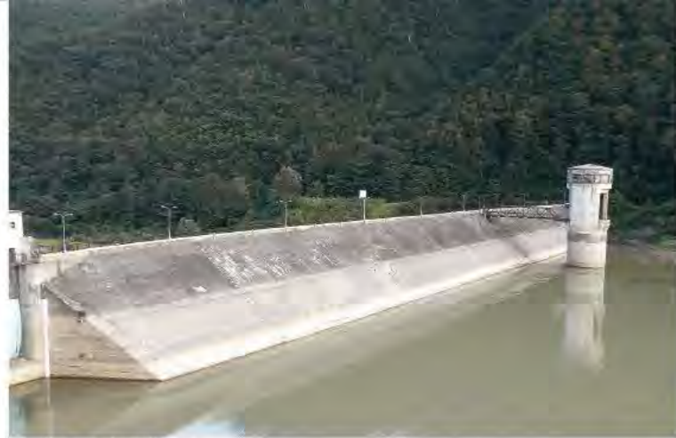
コンクリート表面遮水壁
