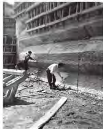
旧堤体のはつり（チッピング）
