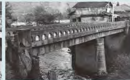
国道鬼ヶ瀬橋
