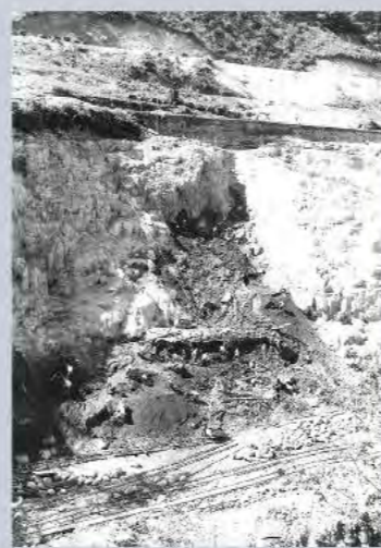
堰堤掘削工事
