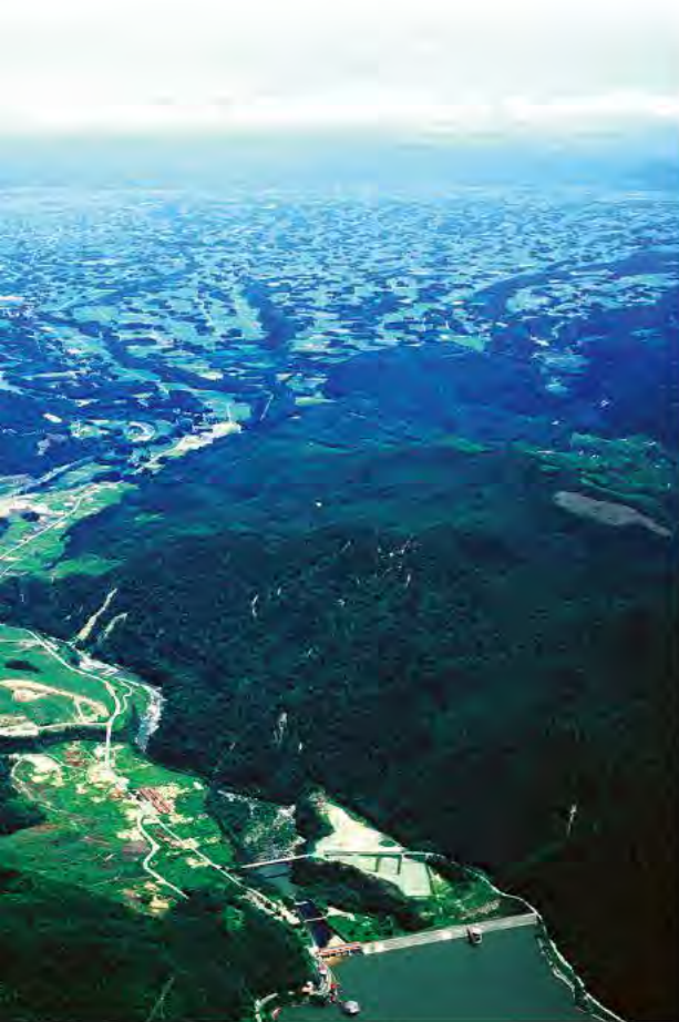
石淵ダム上空から胆沢扇状地を望む
