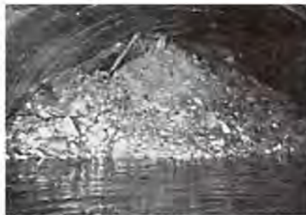
バイパス内上流陥没状況
