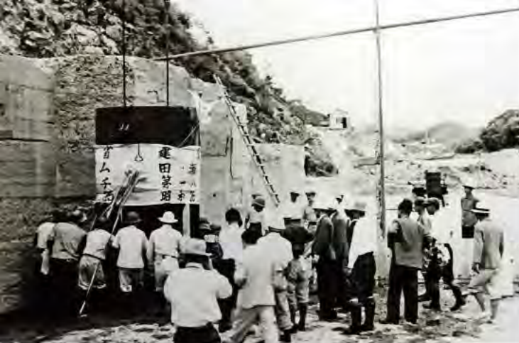
コンクリート打設（定礎式）
