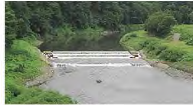
四十四田ダム貯砂床止工（H28.12竣工）
