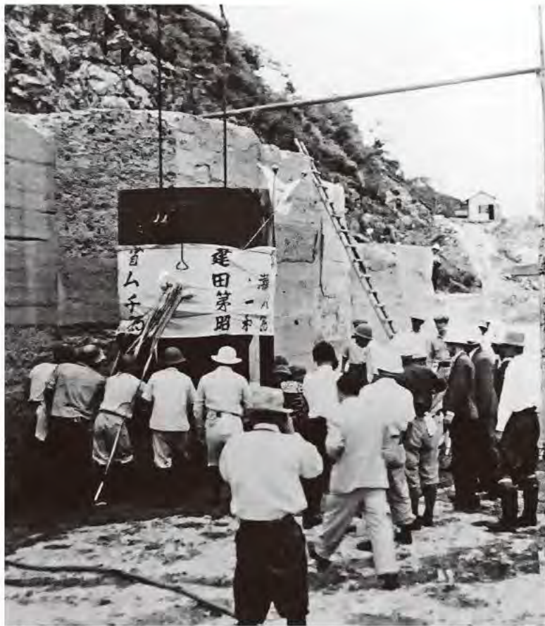
コンクリート打設式
