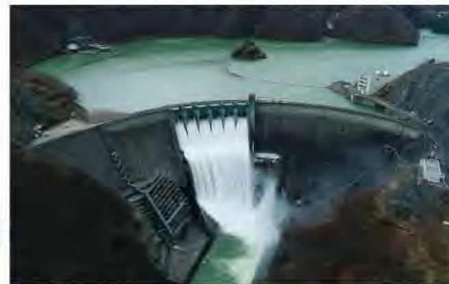
重力式アーチ式の湯田ダム
