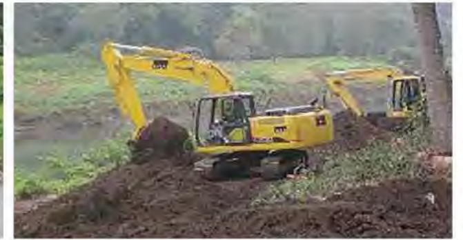
堆積土砂掘削状況
