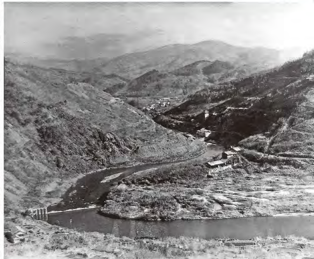
動き出した田瀬ダム建設
