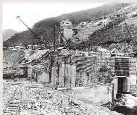
堤体築造中（S18）
