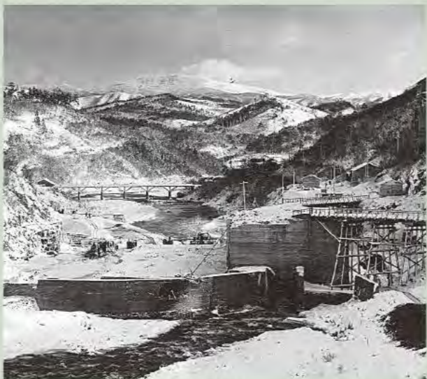
工事が中断された猿ヶ石堰堤（田瀬ダム）
