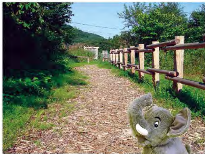
公園内での舗装材として伐採木のチップを利用
