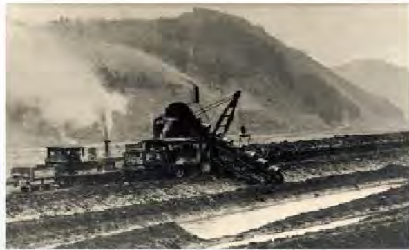
新川掘削状況 昭和6年(1931年)新川通水 ※1
