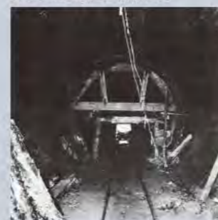
仮排水路コンクリート巻立完成
