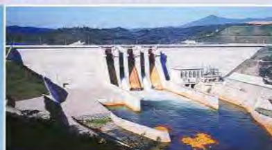
湛水により一夜にして清流が蘇った（完成後）
