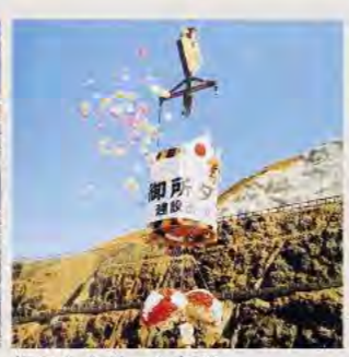
初コンクリート打設
