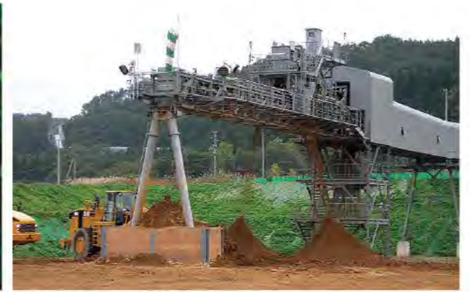
ベルトコンベアによるコア材運搬
