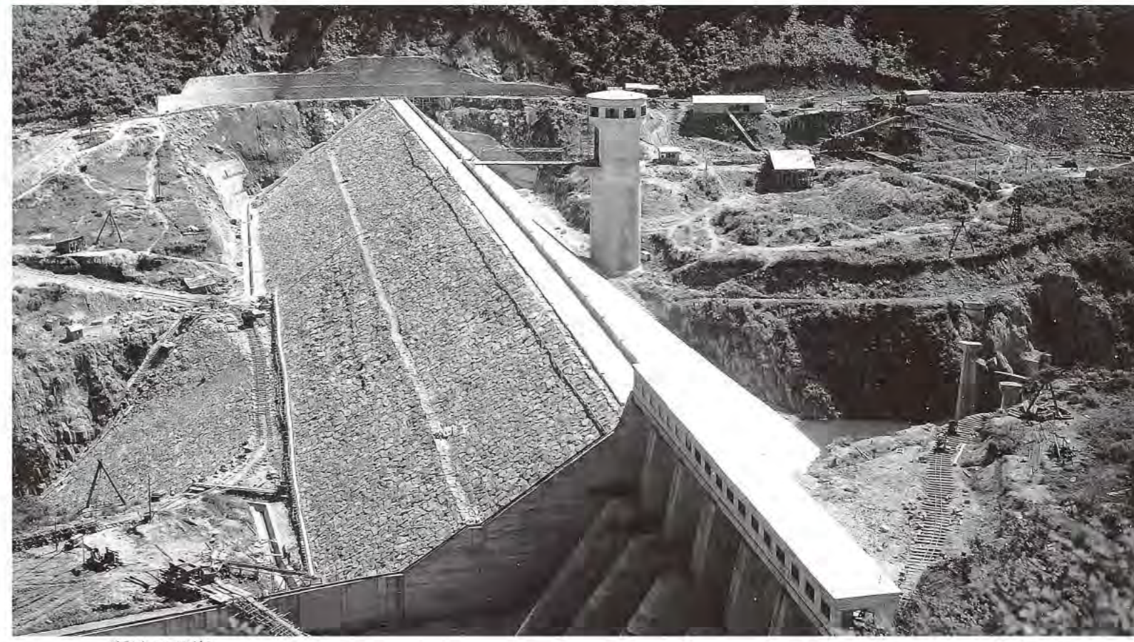
建設中の石淵ダム
