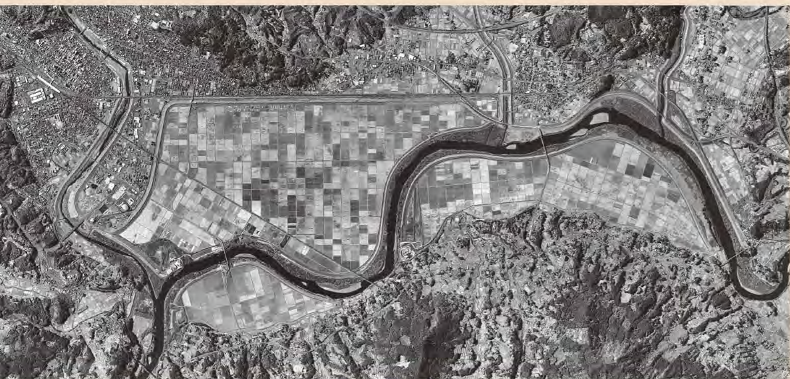
完成間近（平成28年）（周田堤・家屋移転は完了し小堤と排水門の工事も完成間近の一関遊水地）
