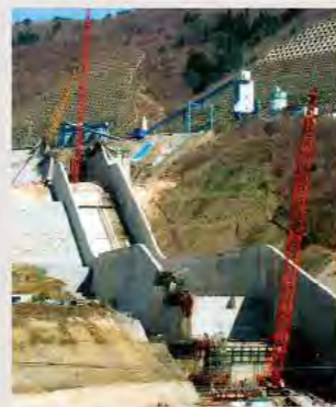
洪水吐コンクリート打設
