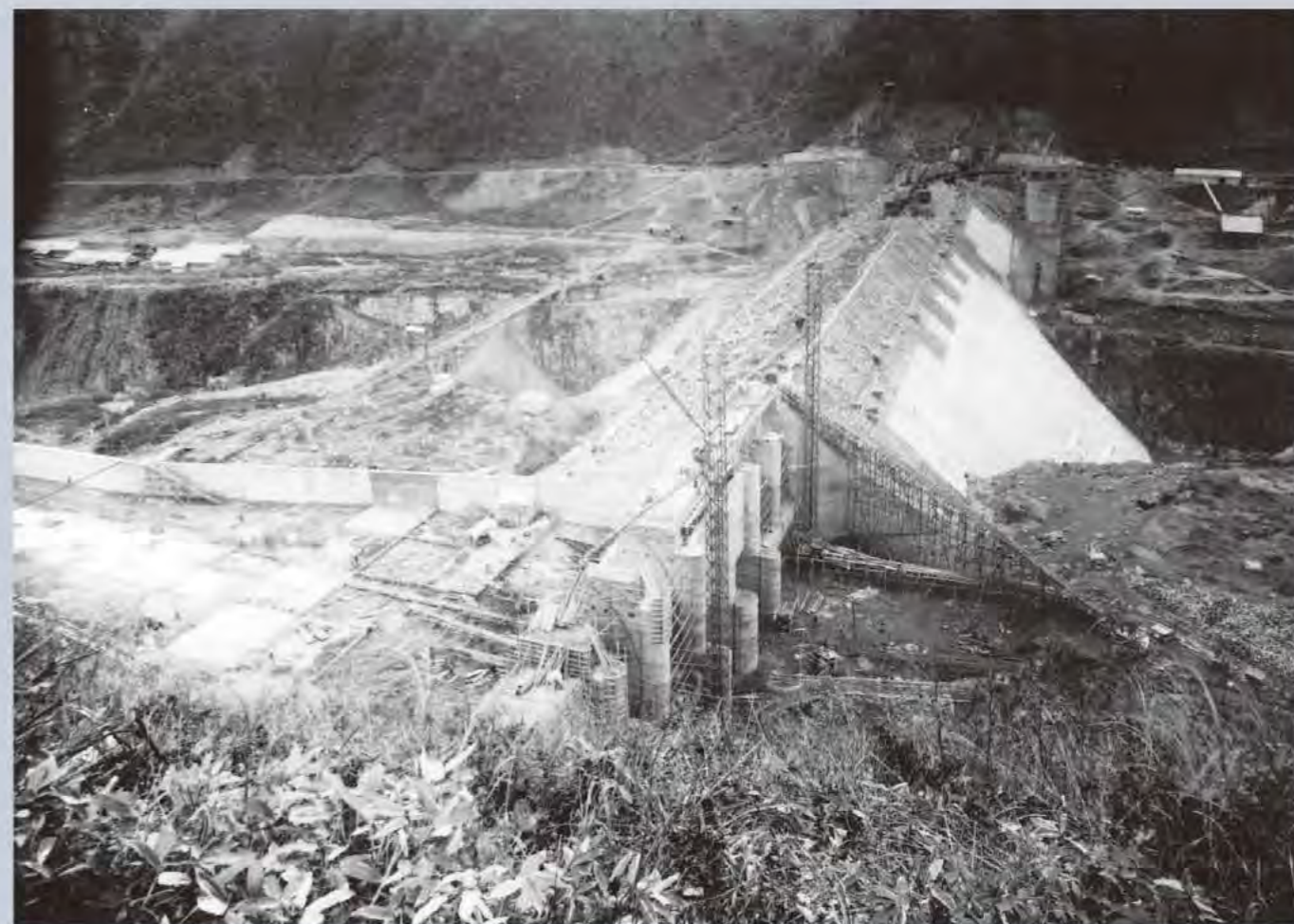
着々と建設が進む石淵ダム
