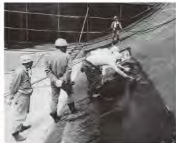
堤体コンクリートへの耐酸塗装工事 ※1
