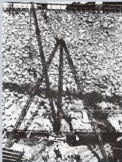
粗石積作業用ステフレッククレーン
