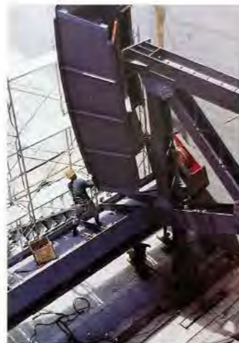
クレストゲート組立状況
