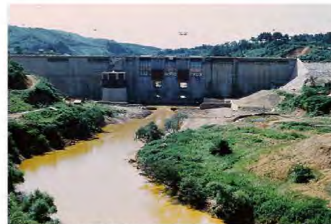
四十四田ダム建設中の北上川は赤褐色
