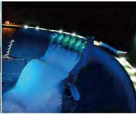
ダム堤体ライトアップ&ナイト放流
