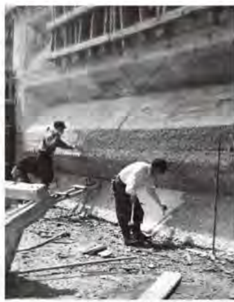
コンクリート表面削り取り
