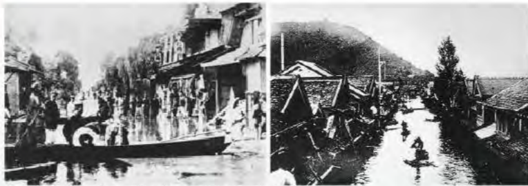
北上川第一期改修の契機となった明治43年洪水状況
