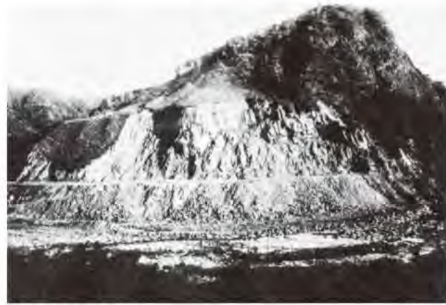
工事竣功後の採石場
