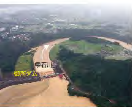
御所ダム付近の出水状況 (H25.8.9)
