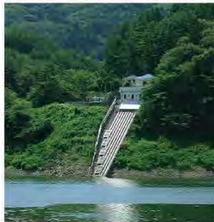
猿ヶ石南部土地改良区の取水口
