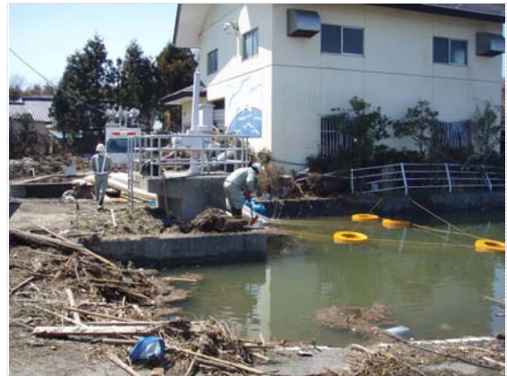
ポンプ設置確認 (4/5)
