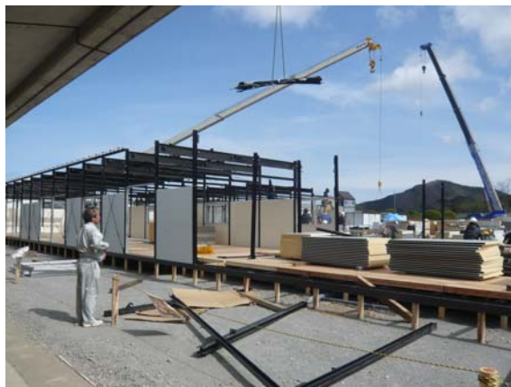
仮設住宅建設進捗状況確認 (5/2)
