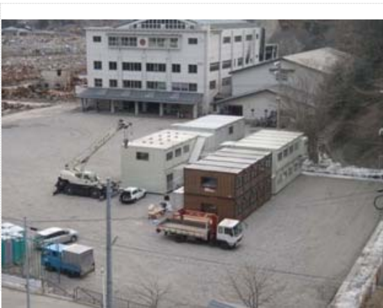
仮調査設置作業終了 (4/3)
