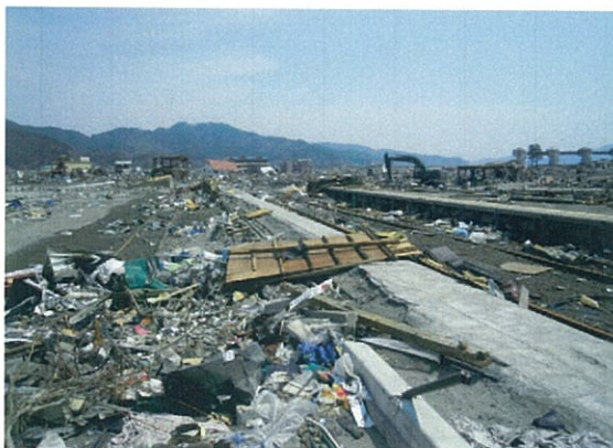
大槌町内被災状況（大槌駅）
