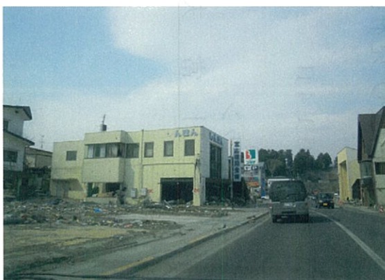
宮古市内被災状況
