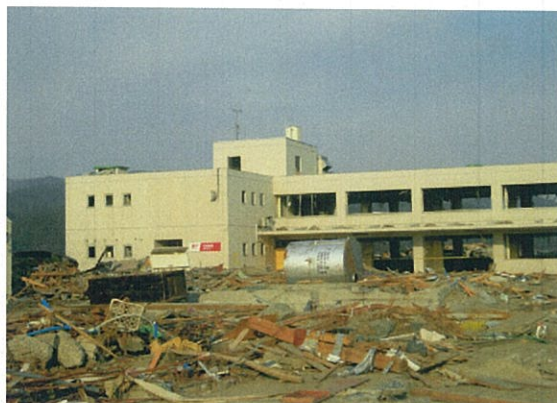
陸前高田市内被災状況
