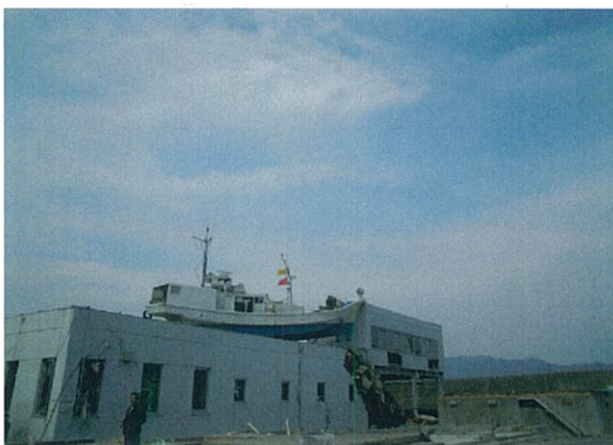
宮古市内被災状況
