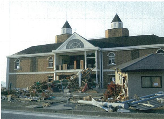
陸前高田市内被災状況
