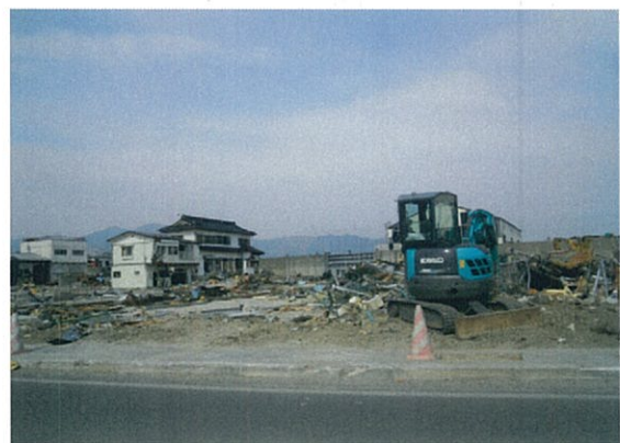
宮古市内被災状況
