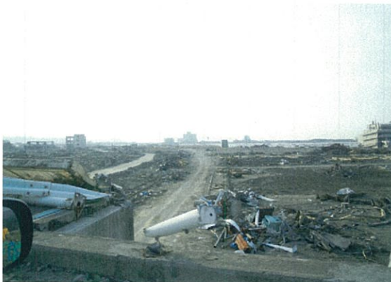
陸前高田市内被災状況
