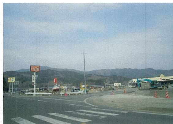
宮古市内被災状況
