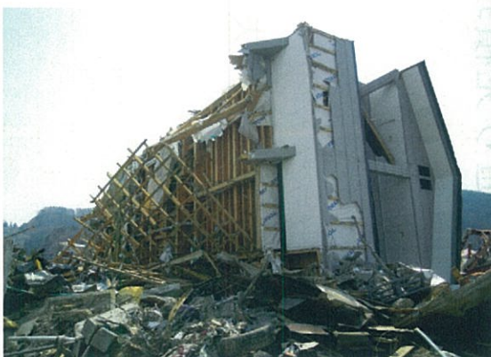
大槌町内被災状況
