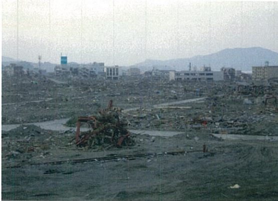
陸前高田市内被災状況
