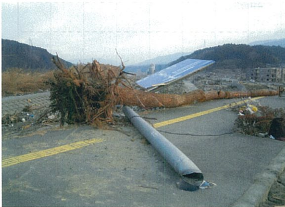
陸前高田市内被災状況
