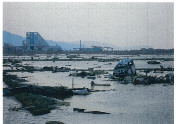
陸前高田市内被災状況
