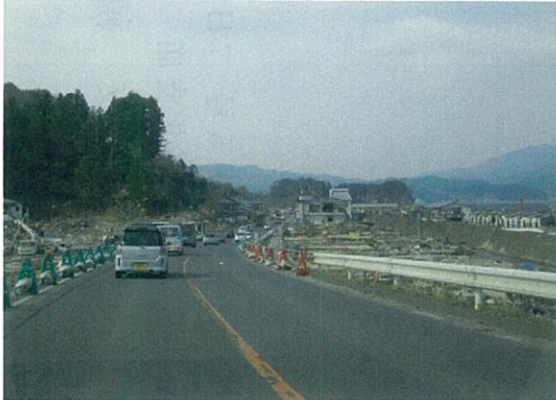
宮古市内被災状況
