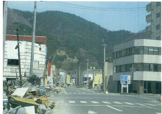
釜石市内被災状況
