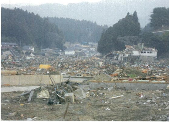
陸前高田市内被災状況
