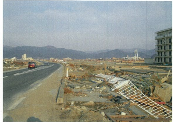
陸前高田市内被災状況
