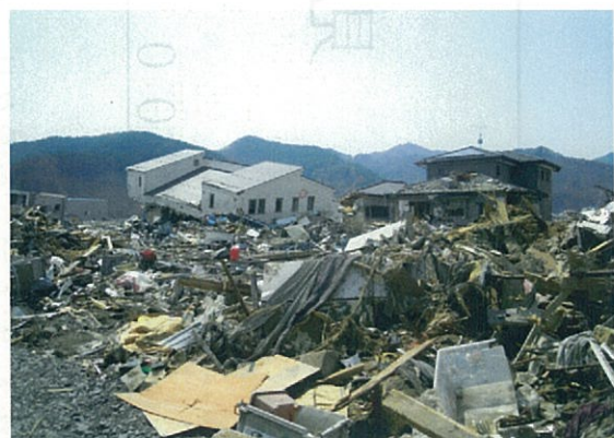
大槌町内被災状況
