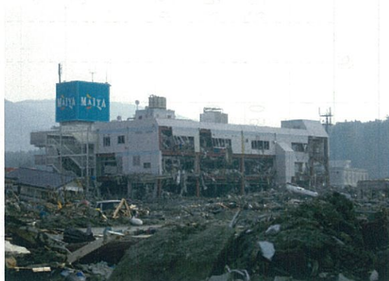
陸前高田市内被災状況
