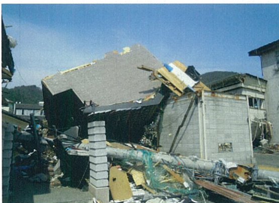
釜石市内被災状況
