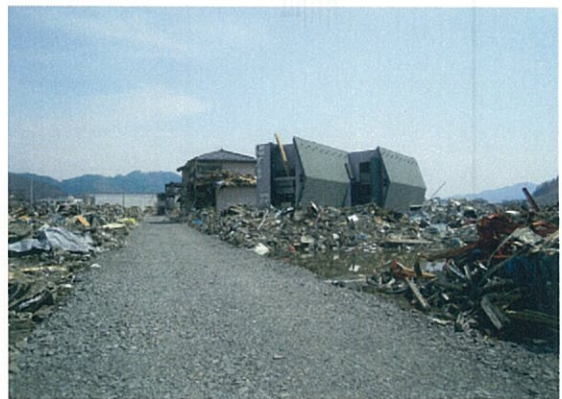
大槌町内被災状況
