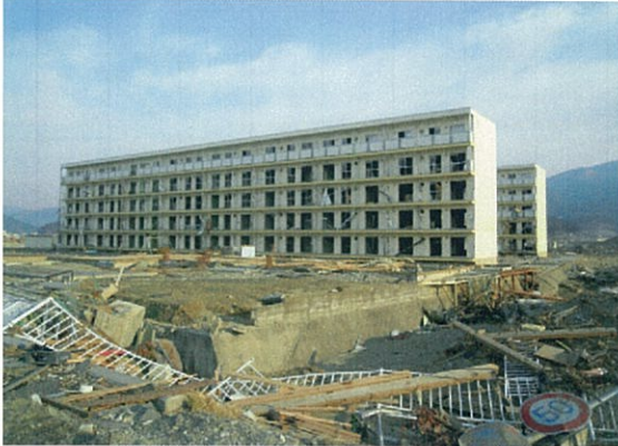
陸前高田市内被災状況(4階まで被災している)
