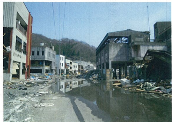
釜石市内被災状況
