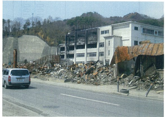
大槌町内被災状況
