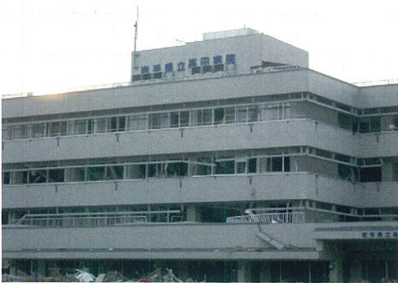
陸前高田市内被災状況
