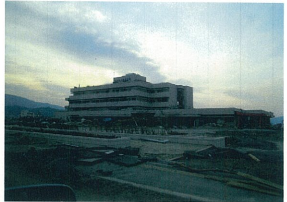
陸前高田市内被災状況
