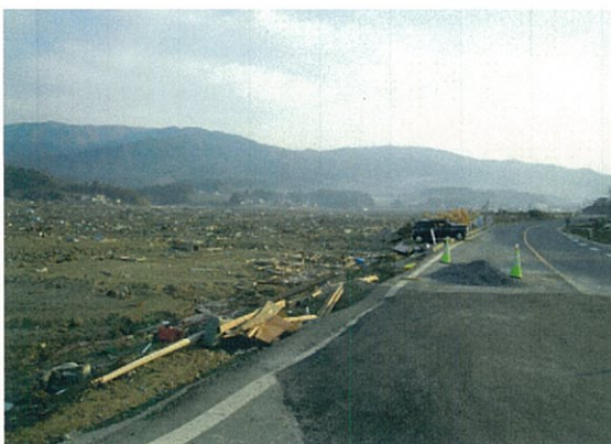
陸前高田市内被災状況
