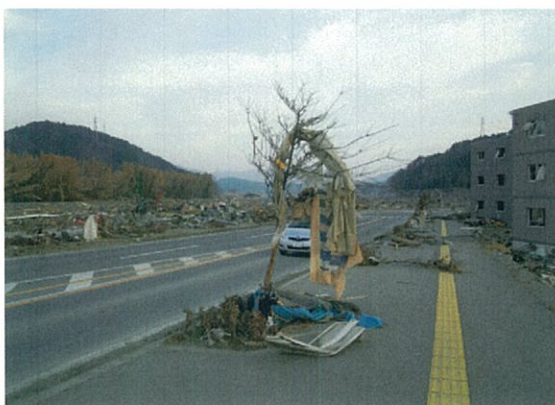
陸前高田市内被災状況
