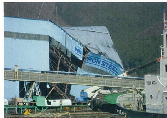
釜石市内被災状況
