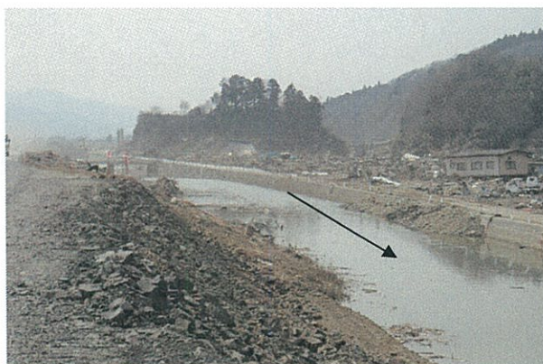
追波川左岸の被災状況
