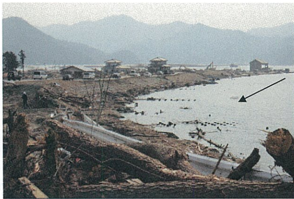
北上大橋付近
