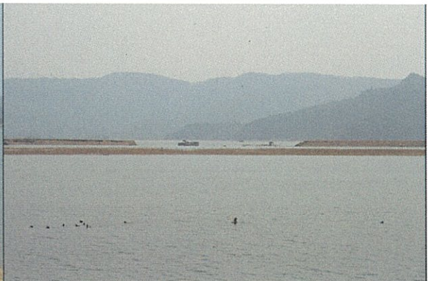
月浜第1水門より河口に約500mより右岸 の破堤状況を望む
