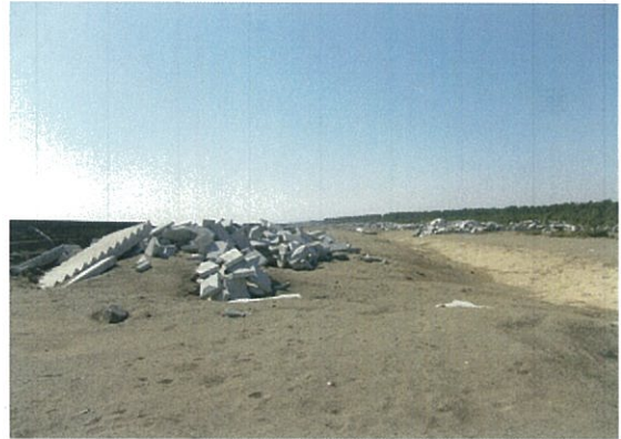
堤内側(南方向)
