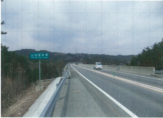
三陸自動車道 山田高架橋路面舗装状況(被害なし)
