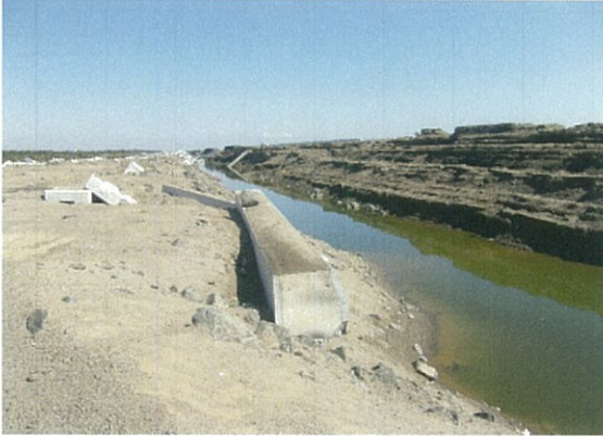
堤内側(施工箇所)
