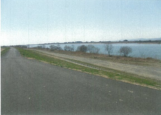
堤防天端より
