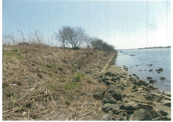
低水護岸部(異常は見られない)
