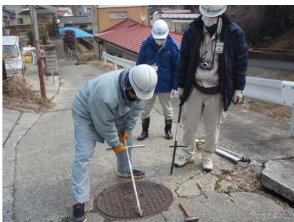
被災マンホールの蓋開け（松島町内）
