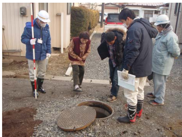
マンホール内の滞水調査（J R愛宕駅付近）
