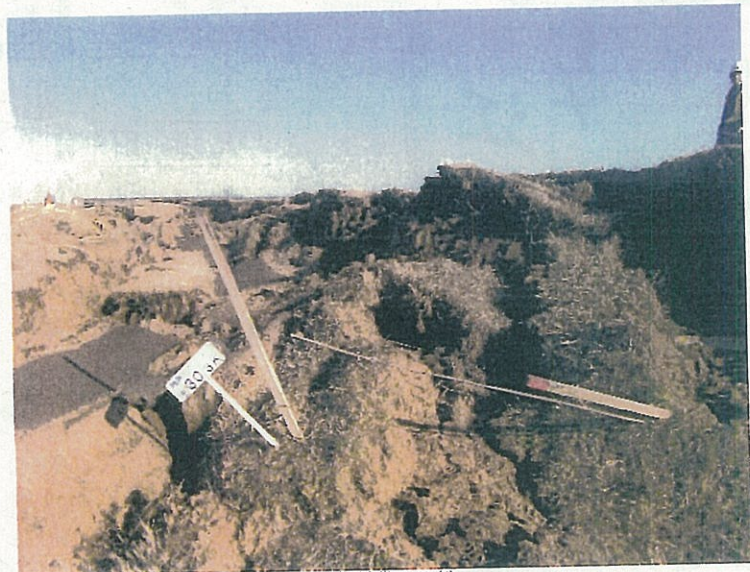
鳴瀬川左岸30. 3k (4) 2011/03/12 15:38 撮影 2011/03/12 15:38:54
