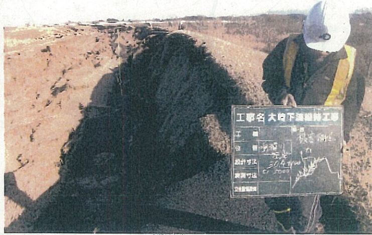
鳴瀬川左岸30. 30k+100 2011/03/12 15:36 撮影 2011/03/12 15:36:07
