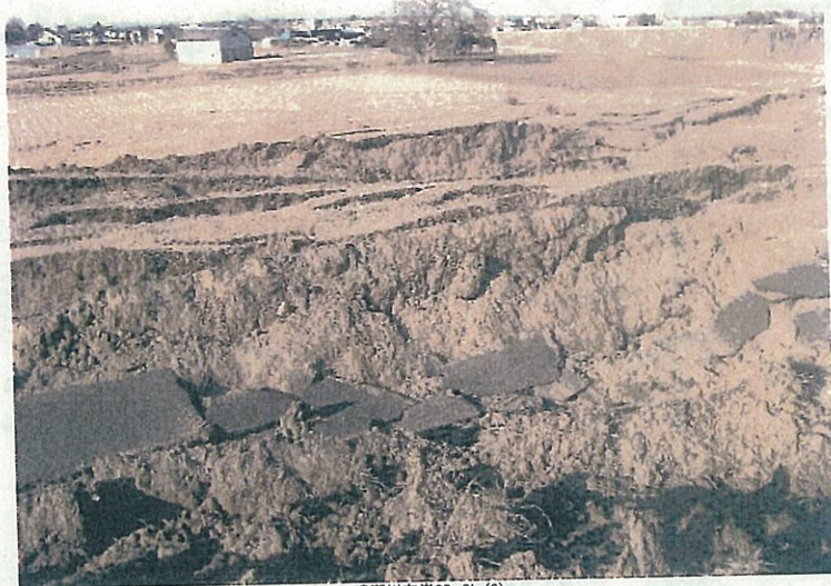
鳴瀬川左岸30. 3k (3) 2011/03/12 15:40 撮影 2011/03/12 15:40:47
