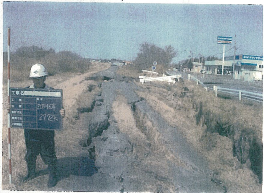
江合橋上流地点から 上流を望む
