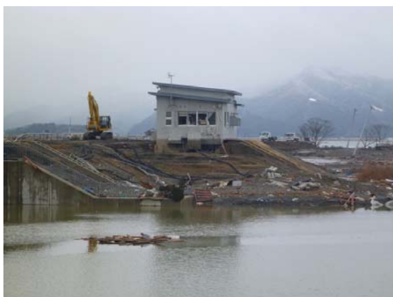
管理棟被災状況
