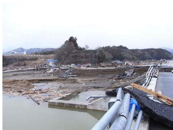
水門から下流の被害状況
