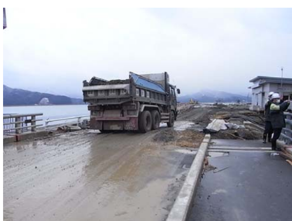
水門上部大型車通行状況
