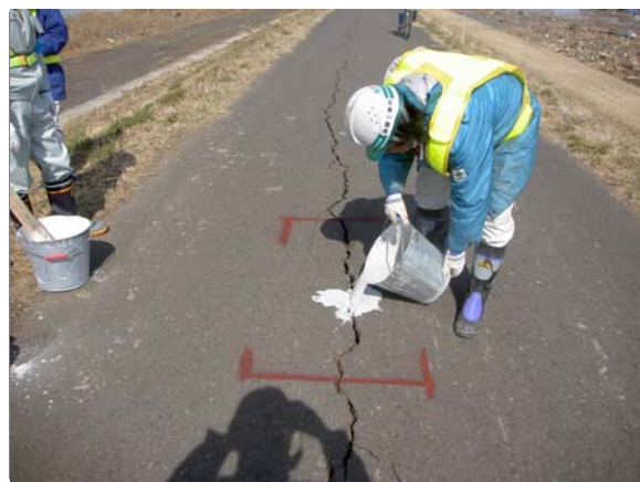
名取川左岸天端クラック石灰注入状況
