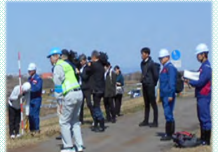
▲秋田河川国道事務所 堤防点検 点検指導 (R8.4.21)
