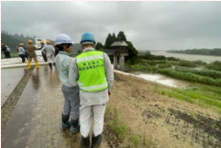
緊急内水排除作業の確認
