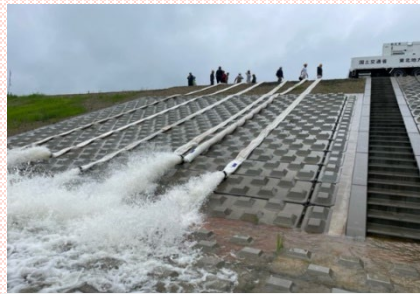
緊急内水排除状況
