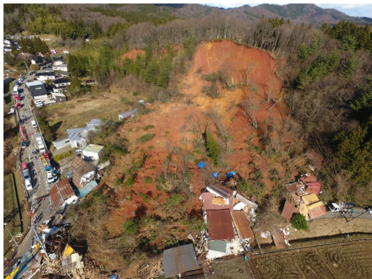
▲現地被災状況写真(令和4年12月31日 UAV撮影)
