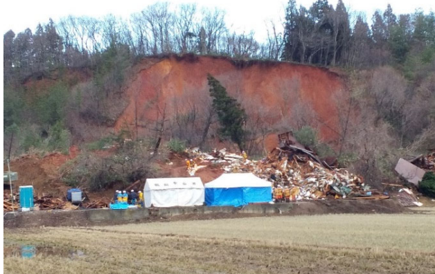
▲被災箇所の状況（令和5年1月1日）
