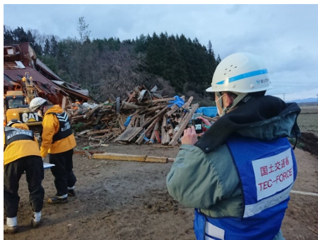
▲被災状況映像配信（令和4年12月31日）
