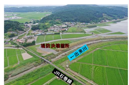
▲出来川堤防決壊箇所（7月19日）
