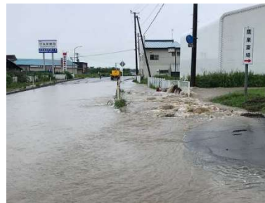
▲国道7号路面冠水による通行止め (北秋田市 8月10日)
