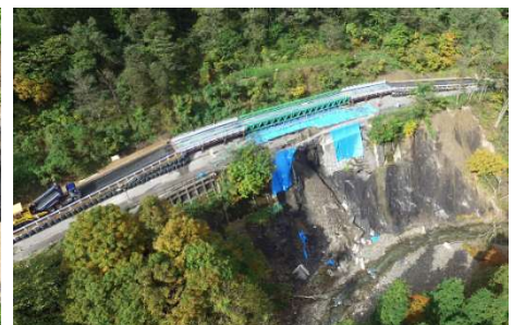
▲国道121号復旧状況
