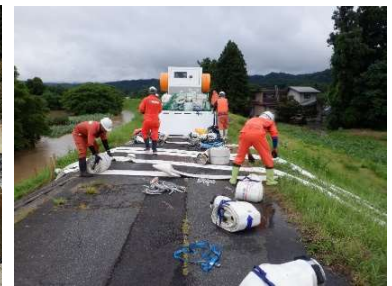
▲最上川水系最上川 白鷹町広野地内 排水作業状況
