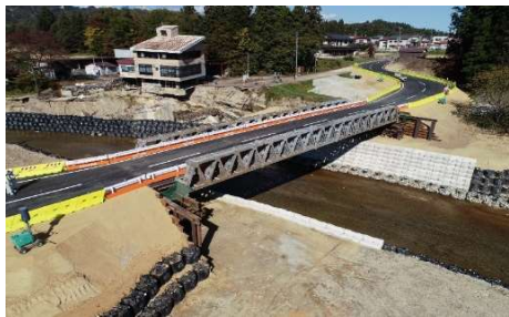
▲応急組立橋設置状況（大巻橋）
