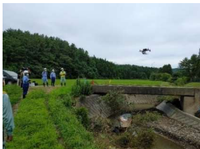
▲青森県中泊町UAV被災状況調査 (8月15日)
