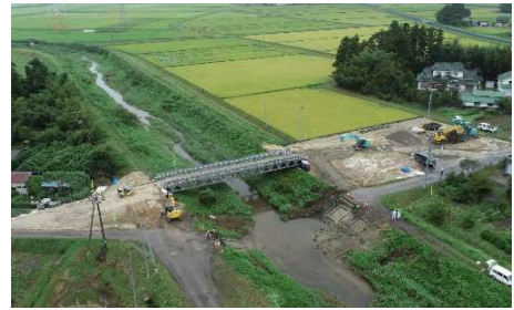
▲応急組立橋設置状況（丸山橋）
