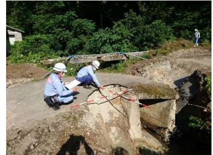
▲道路被災状況調査（川西町 8月6日） [中部地整TEC]
