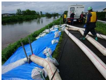
▲岩木川水系旧大峰川 弘前市小友 排水作業状況
