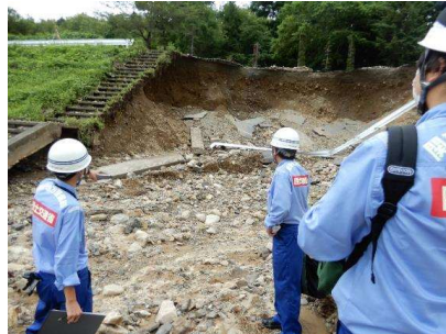
▲道路被災状況調査（長井市 8月5日） [関東地整TEC]
