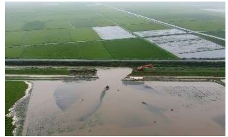
▲岩木川水系中里川堤防決壊(8月10日)
