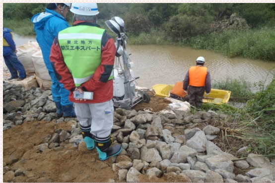
▲破堤状況確認 (破堤箇所の深さの調査)
