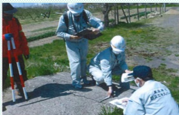
▲徒歩点検(阿武隈川上流堤防)
