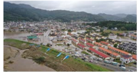
図-2:排水作業状況
