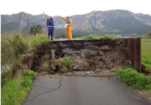
阿蘇市・乙女川堤防の沈下(段差約1.6m)
