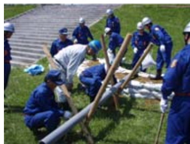
月の輪工法指導の様子 ▶
