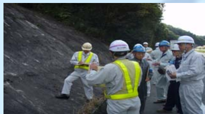
10/15米沢国道維持、災害復旧現場視察
