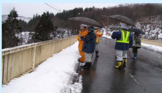
11/21 白川ダム 現場視察
