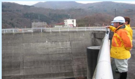
11/17 寒河江ダム 現場視察
