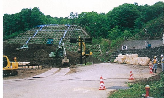
応急対策(押え盛土)
