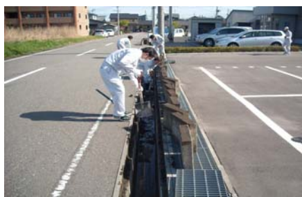
・酒田事業所（市道部側溝泥上げ）【山形支所】
