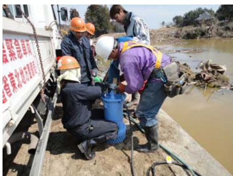
排水ポンプの設置状況
