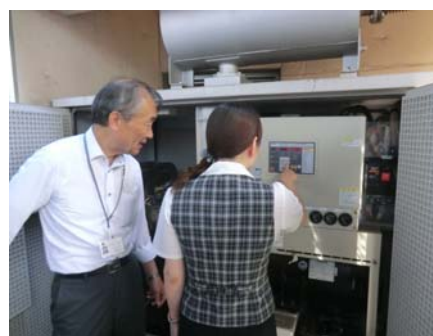
非常用発電機試運転の様子
