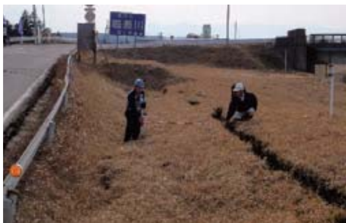
▲鳴瀬川右岸の被災
