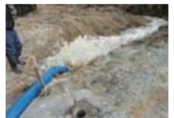
▲ポンプ設置から排水まで約1時間
