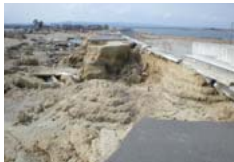
▲阿武隈川河口の被災堤防
