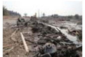
▲自衛隊立会いのもと素掘り排水路を掘る
