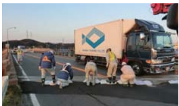
国道6号段差応急復旧作業 (4月12日)
