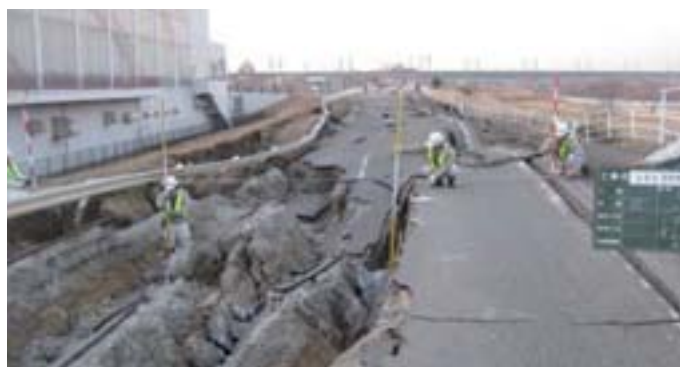
江合川の緊急復旧状況
