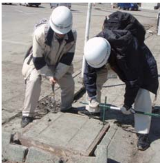
国道6号橋梁点検(4月2日)
