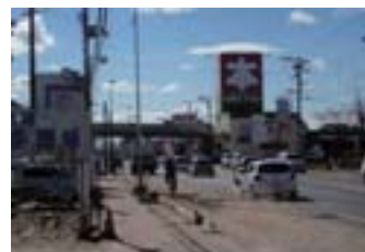
▲開放4車線確保 (4月4日 15:00)
