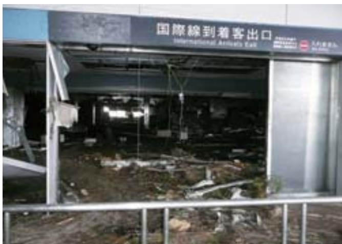
▲仙台空港の内部状況
