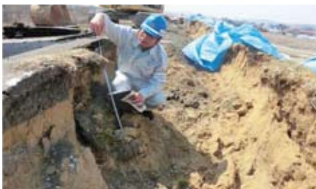
北上川被害調査(4月13日)
