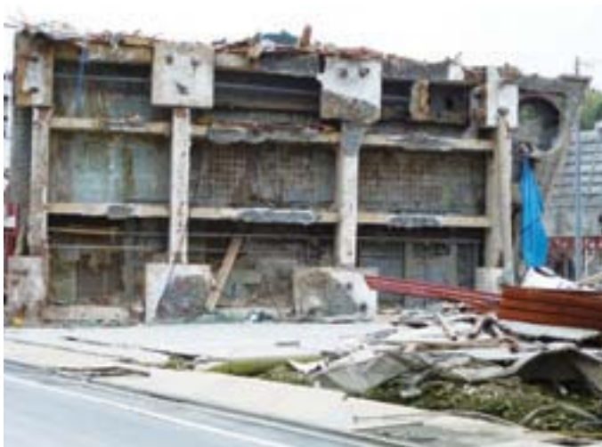
▲女川町 倒壊した建物(基礎杭が引き抜かれている。右端の杭)
