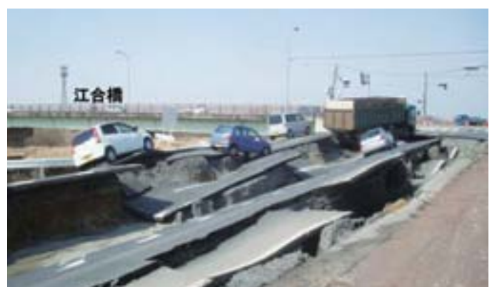
江合川左岸被害状況(3月13日)
