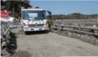
▲排水ポンプ車の稼働状況 (水神沼)
