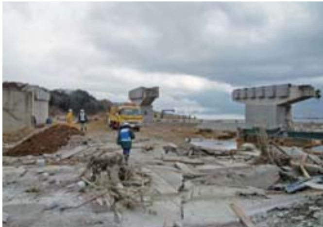
国道45号沼田跨線橋調査(4月5日)
