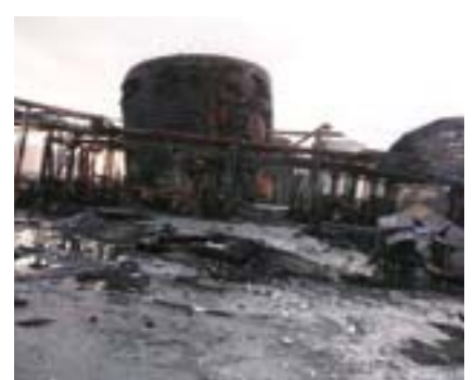
▲仙台石油精製所の焦げたタンク
