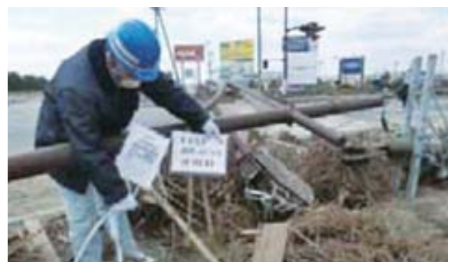
国道45号遺構被害調査(4月3日)
