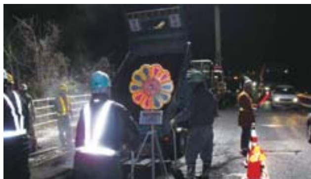
国道4号段差補修 交通誘導 (3月11日)
