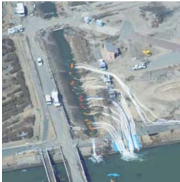
仙台空港排水状況(3月17日)
