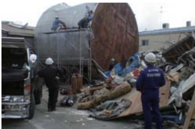
タンク撤去のための現地調査(東北地方整備局リエゾン)
