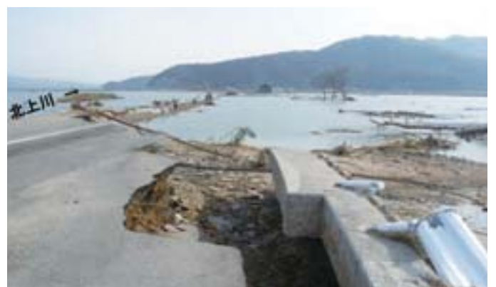
北上川右岸被害状況(3月13日)
