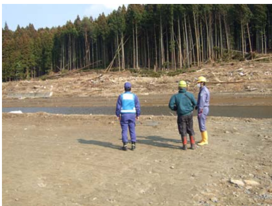
排水ポンプ設置箇所現地確認 (3/29)
