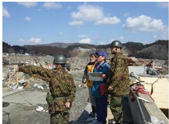
排水ポンプ設置立会打合せ (3/24)
