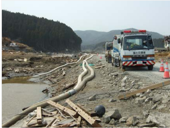
明神池(一の池)排水状況確認 (1回目) (4/2)
