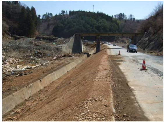
補修工事状況確認 (4/12)
