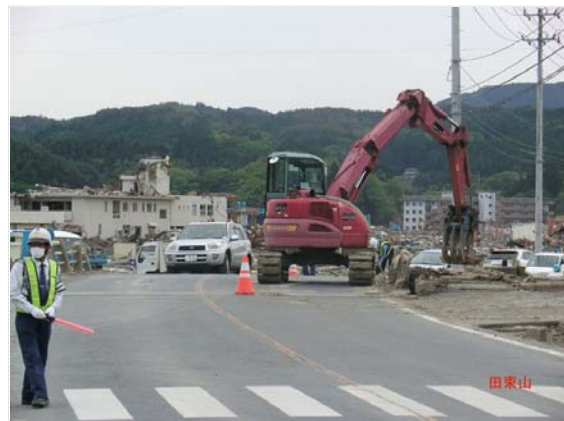
国道 45 号歩道部瓦礫撤去状況 (5/23)
