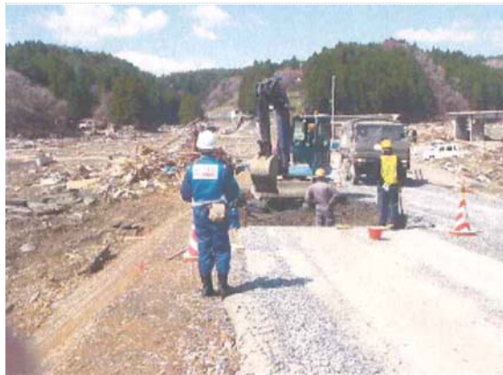
応急復旧工事確認状況 (4/24)
