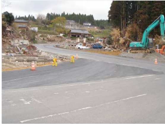
歌津大橋迂回路拡幅状況 (5/6)
