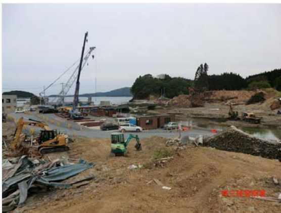
国道 45 号水尻橋仮橋設置状況 (5/23)
