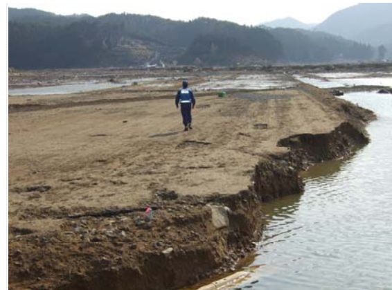
排水ポンプ設置箇所現地確認 (3/29)
