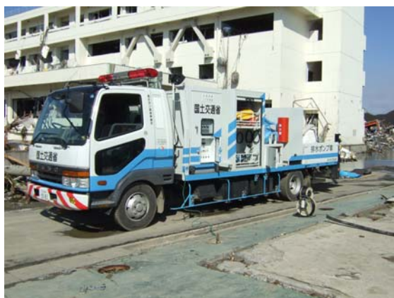
排水ポンプ車配置立会い (3/26)
