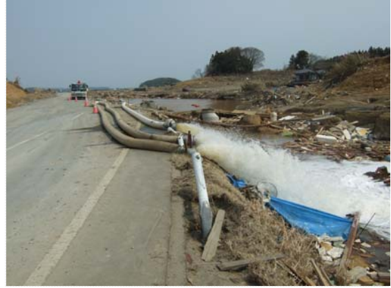
明神池(一の池)排水状況確認 (1回目) (4/2)
