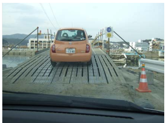
水尻橋・仮橋設置状況 (4/7)
