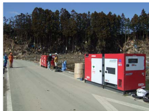
発電・コンプレッサ設置立会い (3/27)
