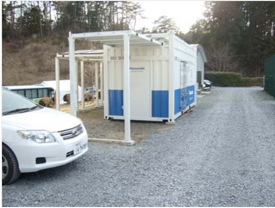
ソーラー発電設備 (4/9)
