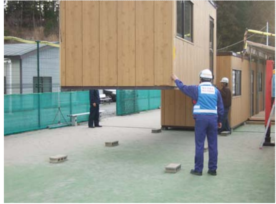
プレハブ設置状況 (4/9)
