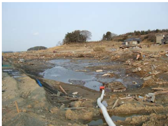
明神池(一の池)排水状況確認 (3回目) (4/2)
