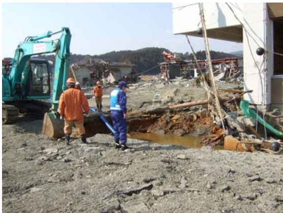
排水ポンプ設置同行状況 (3/29)
