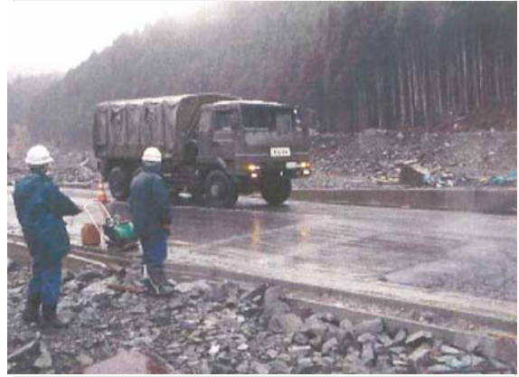
仮舗装工事確認状況 (4/23)
