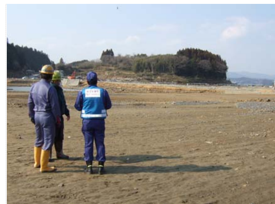
排水ポンプ設置箇所現地確認 (3/29)
