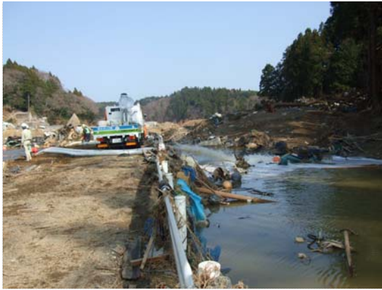
排水状況確認・田の浦地区 (4/10)
