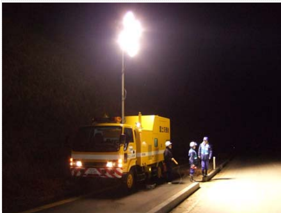
照明車設置立会い状況 (3/27)
