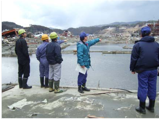
排水ポンプ車配置現地確認 (3/26)
