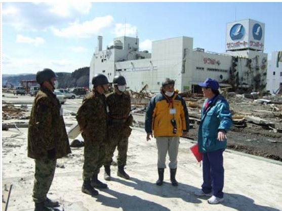
排水ポンプ設置立会打合せ (3/24)
