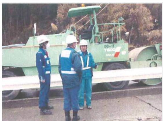
仮舗装工事確認状況 (4/22)
