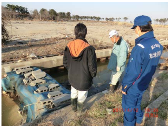
排水状況確認 (4/12)
