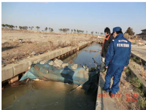
排水状況確認 (4/12)
