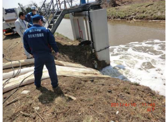
排水状況確認 (4/10)
