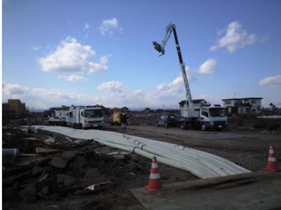
排水状況① (3/23)
