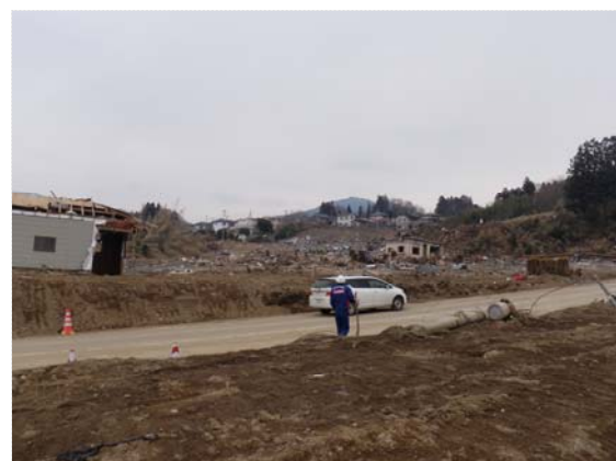
被災状況確認 (3/31)
