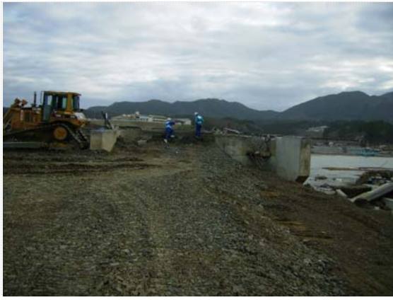
現地調査状況（4/20）
