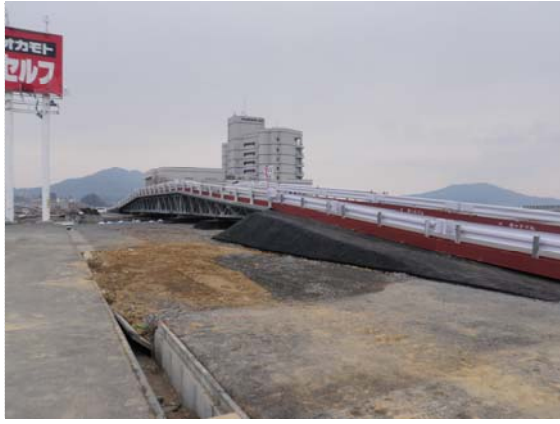
川原川橋・仮橋 (3/31)
