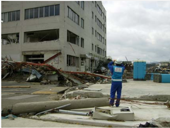
現地調査状況（4/21）
