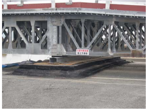
川原川橋・仮橋 (3/31)
