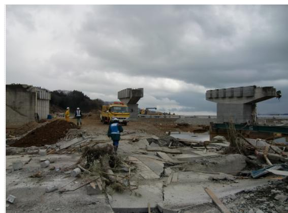
国道 45 号沼田跨線橋主桁落橋
