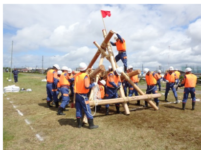
▲伝統工法「川倉工」
