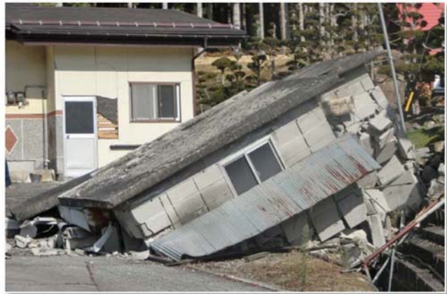
コンクリートブロック造の倒壊（白馬村）
