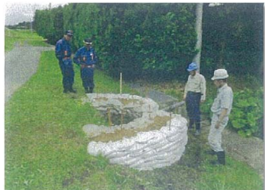
吉田川右岸堤防・堤体漏水対応 (6/20)
