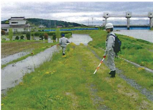
江合川・漏水箇所調査 (5/4)
