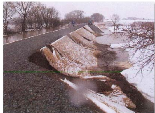
岩木川白子地区・堤防小崩落状況 (3/31)
