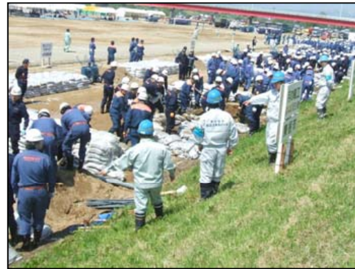
最上川水防演習_月の輪工法指導状況 (山形)
