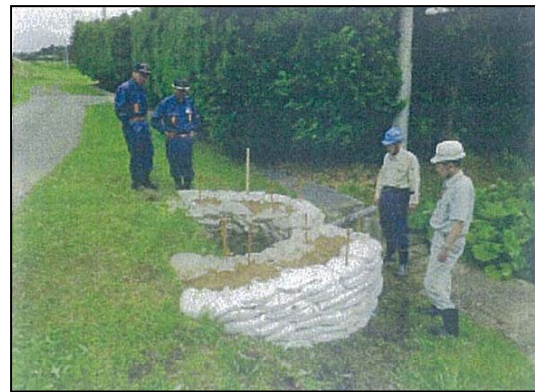
吉田川右岸堤防・堤体漏水対応状況 (6/20)
